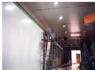
Parede térmica divisória
