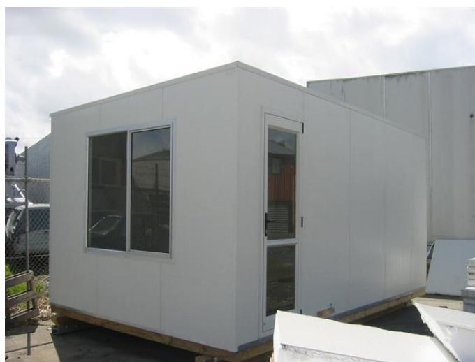
Alojamento de obra
