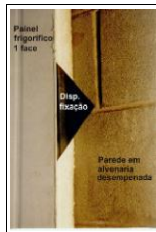
Detalhe da fixação Painel 1 face
